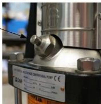
Рис.8 Пробка воздухоборника.
